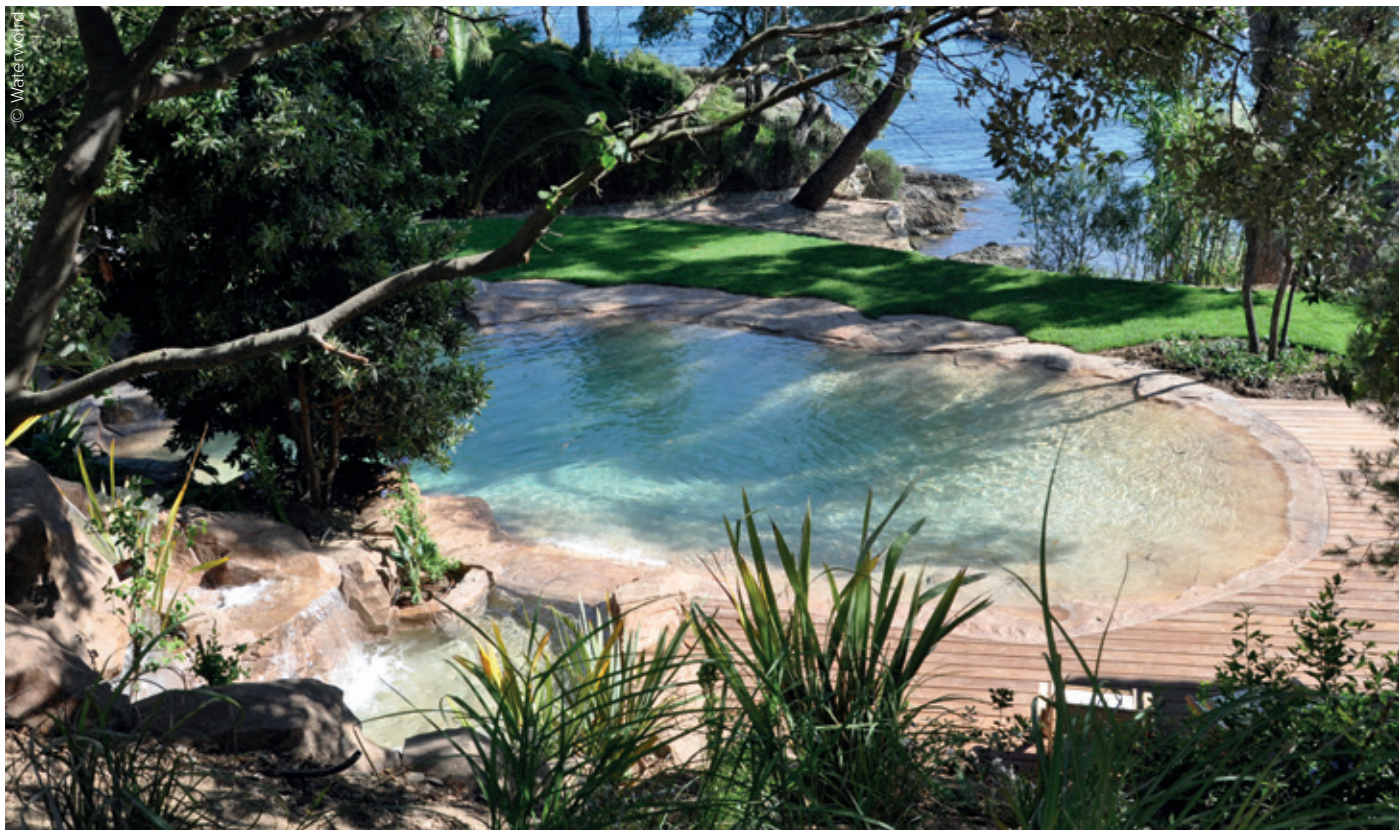
La plage immergée, dans la continuité du profil du fond, en forme de cuvette, permet un accès aisé, agréable et ludique à la baignade. Il n'y a pas de margelles à proprement parler, le pourtour de la piscine est composé en partie de roches plates reconstituées.
