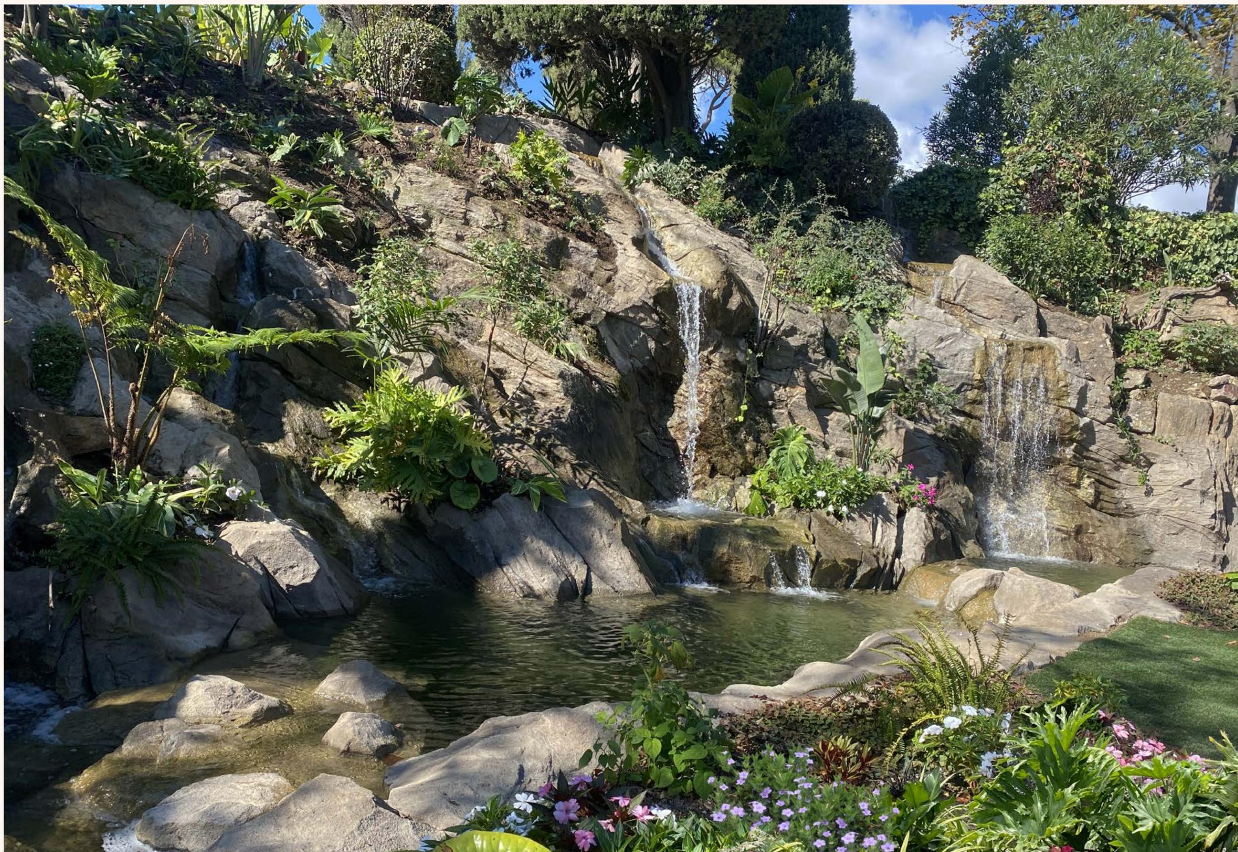
Nos cascades sont construites en béton armé et rochers reconstitués avec de nombreuses réservations pour la végétation. L'arrosage et l'éclairage sont dissimulés dans les rochers.
